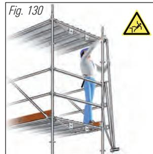
1. Premontar la viga puente, la base collarín y la diagonal.
