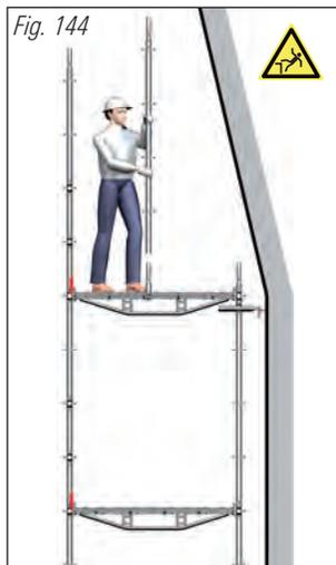
3. Colocar las plataformas y sus cierres de seguridad.
