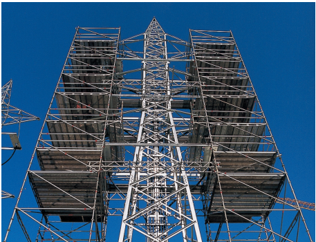
Pórtico realizado con diagonales Allround (Diagonal a tracción).
