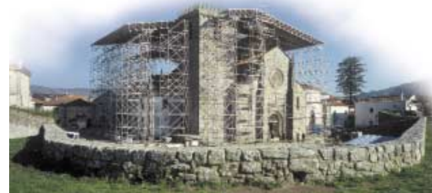
► Cubierta de acero
